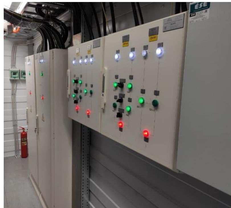
Система ввода и распределения питания в МЦОД
