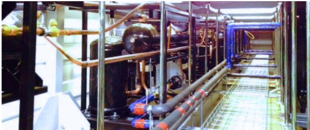
Расположение кондиционеров Clever Breeze под фальшполом
