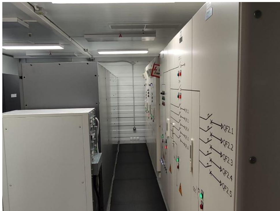
Система бесперебойного питания в МЦОД
